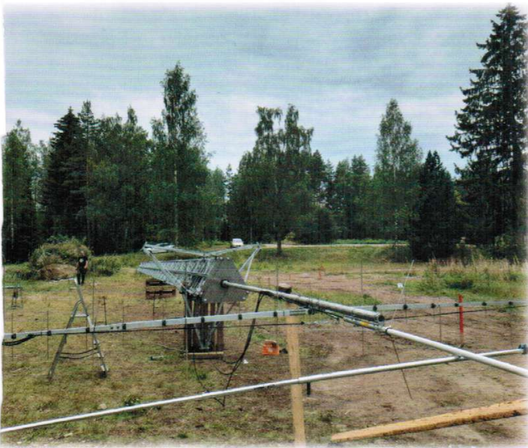
Antenneja paikoillaan ennen nostoa.
