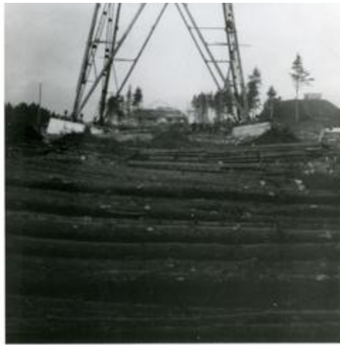
Lahden radiomasto rakenteilla. Taustalla näkyy vanha radioasema ja vesisäiliö. Kuvan yhteydessä erillisellä lapulla teksti: ”Kun radiomastojen ensimmäiset teräspalkit saatiin pystyyn.” Kuva vuodelta 1927. LAHDEN KAUPUNGINMUSEO (CC BY-ND 4.0)
