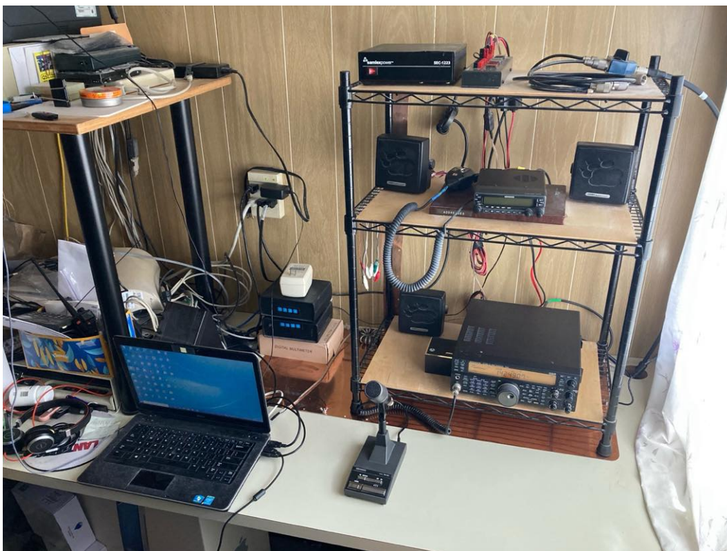
Kuva 4. Davidin radioaseman laitteisto. Antennit ovat aivan ulkopuolella, oikealla.
