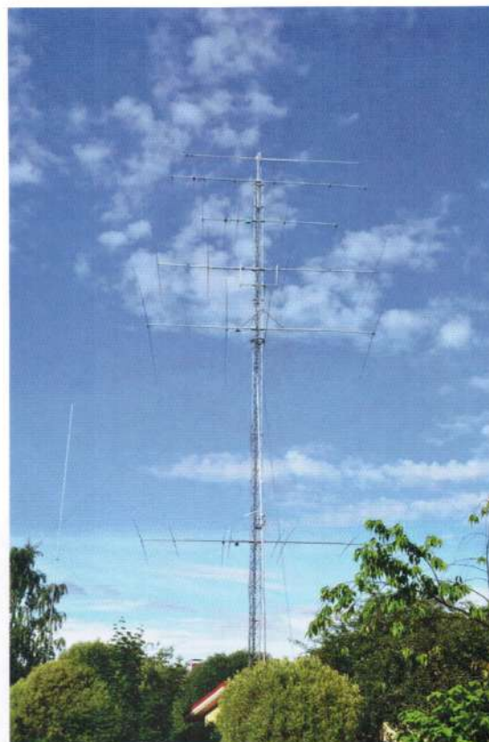
Tapani Rynänenin radioaseman masto ja antennit.
