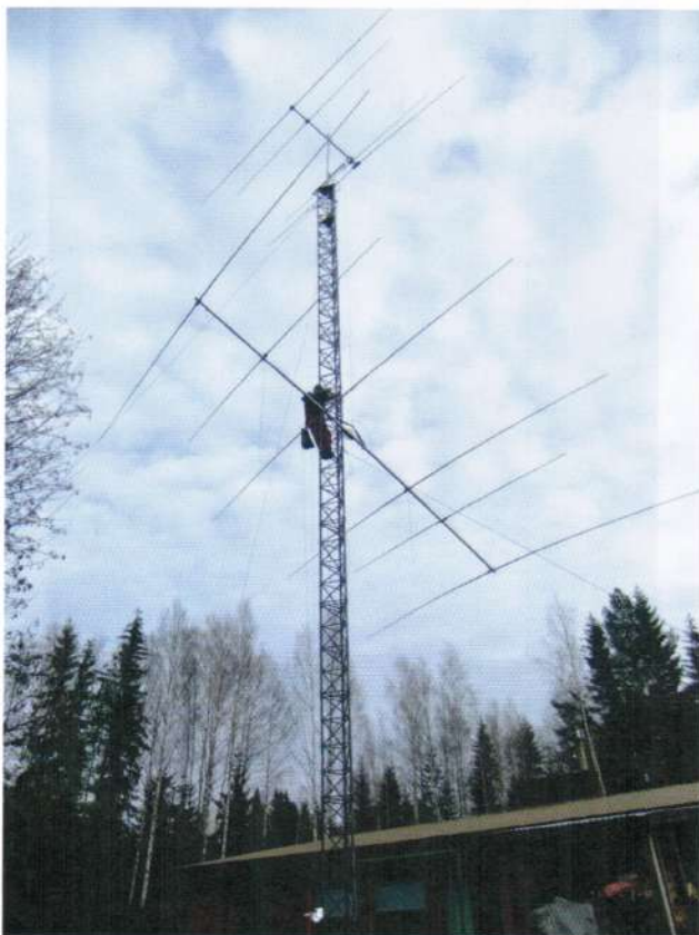
Ari Ryynänen tuomassa antennia alas mastosta.
