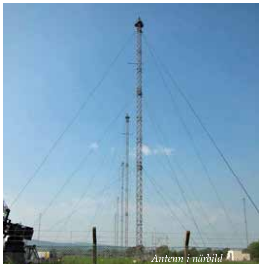
Antenn i närbild
